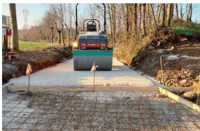
TERZO LOTTO CICLABILE POSA PAVIMENTAZIONE CALCESTRE
