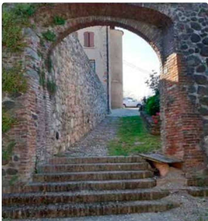
Scalinata da riqualificare lato sud ovest
