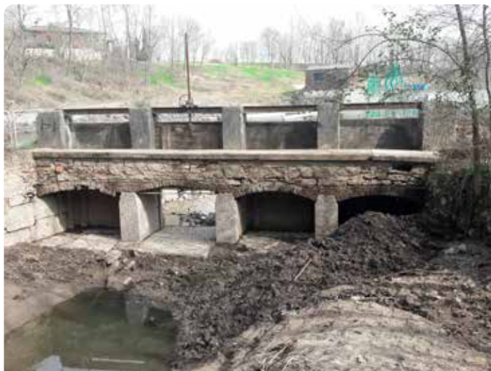
La chiusa prima dei lavori
