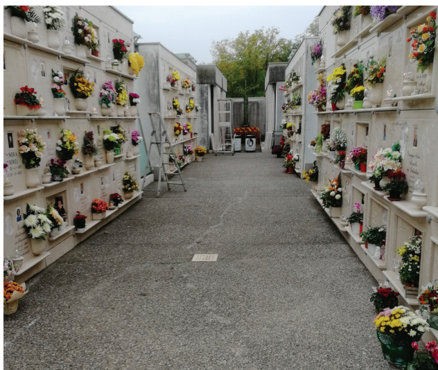
Il cimitero sarà interessato da importanti lavori di manutenzione straordinaria
