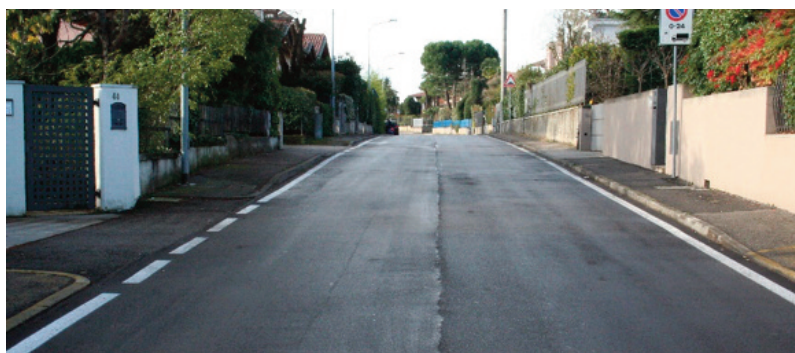
interventi di manutenzione e asfaltatura di numerosi tratti stradali e marciapiedi
