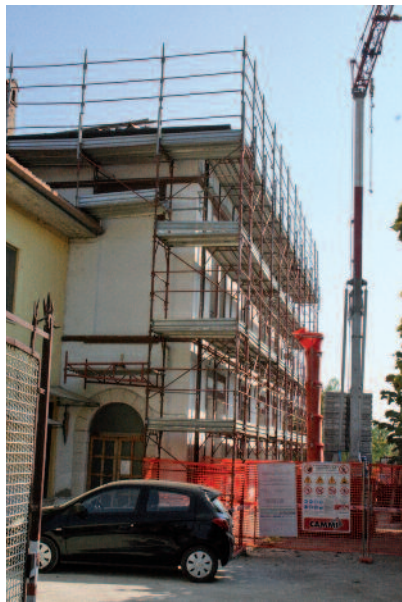
Cantiere Housing Sociale di San Vito
